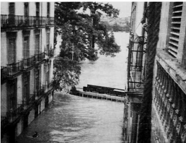
Carrer del Pare d'Òfens, al barri del Carme. Al fons, el riu ple d'aigua
